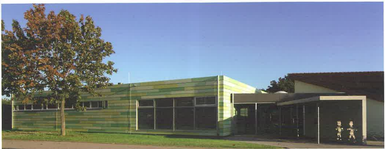
Bild 5: Eingangsbereich zwischen Altbau und Erweiterungsbau
