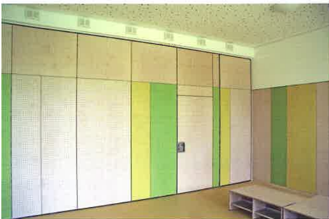
Bild 8: Innenaufnahme der mobilen Trennwand zwischen Eingangsbereich und Bewegungsraum
