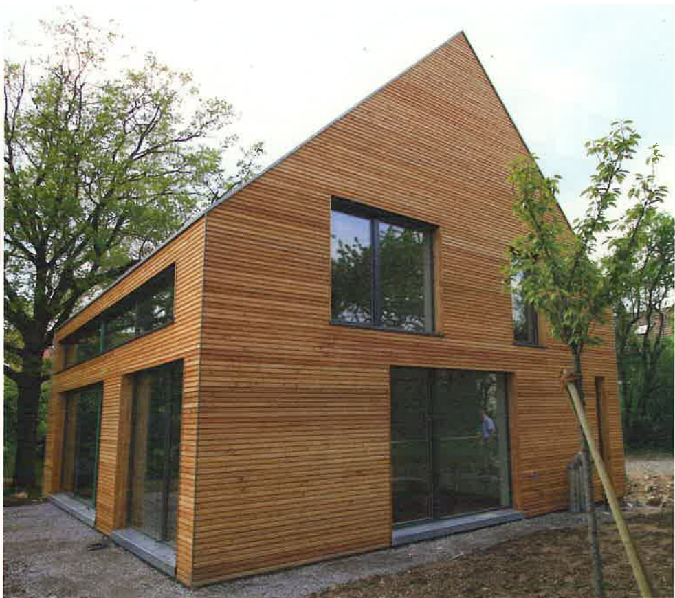
70771 Leinfelden-Echterdingen, Holzbau Ulrich Zeh
