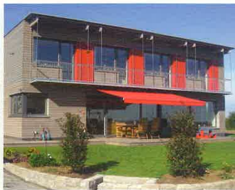
61231 Bad Nauheim, architekt martin wamsler
