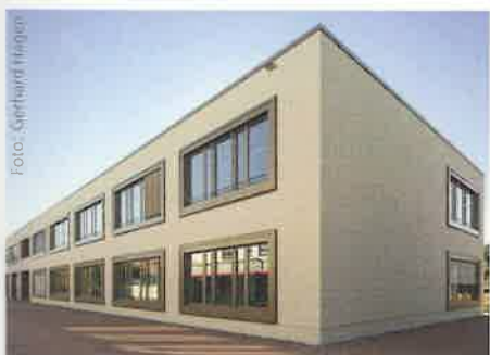
91438 BAD WINDSHEIM (SPORTHALLE) BAURCONSULT Architekten + Ingenieure
