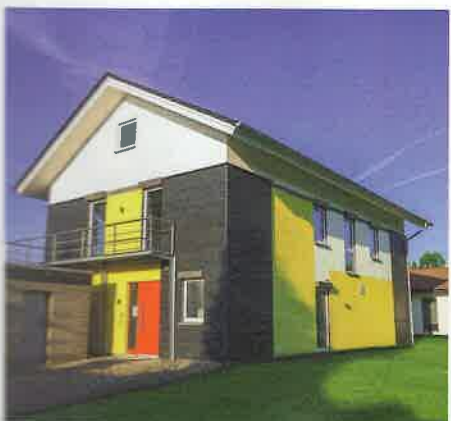
82269 RÖDINGHAUSEN Hausbau Heggemann
