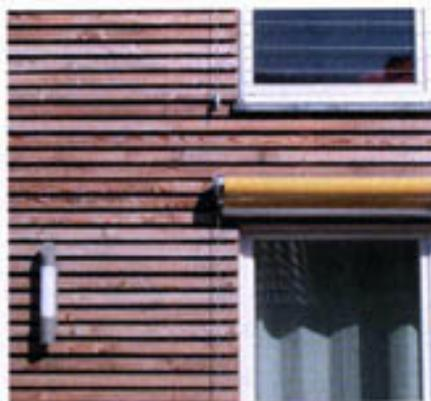
12,5 mm Fermacell, 30 mm Lattung, Dampfbremse  $sd = 2,3m$ , 356 mm TJI-Träger mit  $e = 833$  mm, 356 mm Zellulosedämmung  $WLG 040$ , 16 mm DWD Holzfaserplatte, Tonziegel. Im hohen Mittelbereich teilweise Akustikverkleidung mit gelochten OSB-Platten. U-Wert:  $0,11$   $W/m^2K$  (97% Gefach, 3% Ständer)
